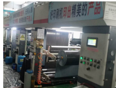
多色印刷机安装调试
