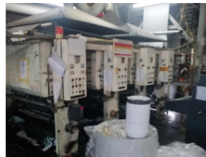
多色印刷机安装调试
