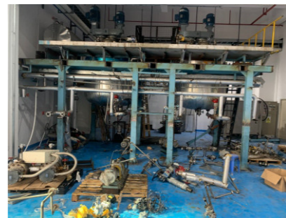
韩国设备树脂加温搅拌罐安装
