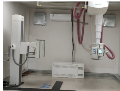
影像机调试布线安装
