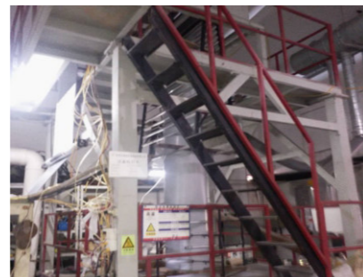
多色印刷机安装调试
