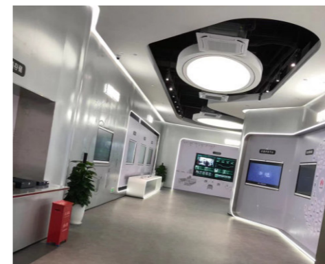
网络展厅屏幕布线及安装调试
