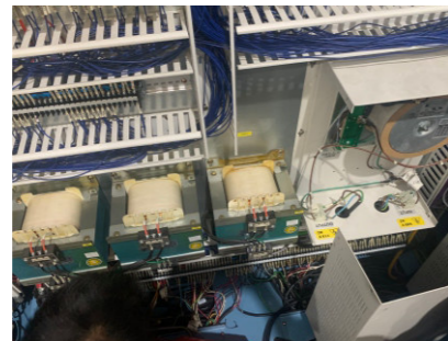
进口含浸机控制箱安装与调试
